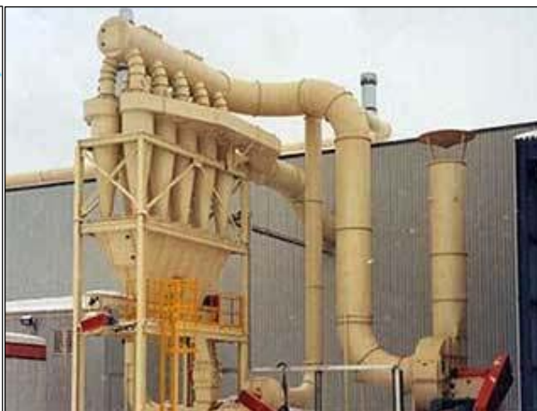
Слика 16 Мултициклонска инсталација
